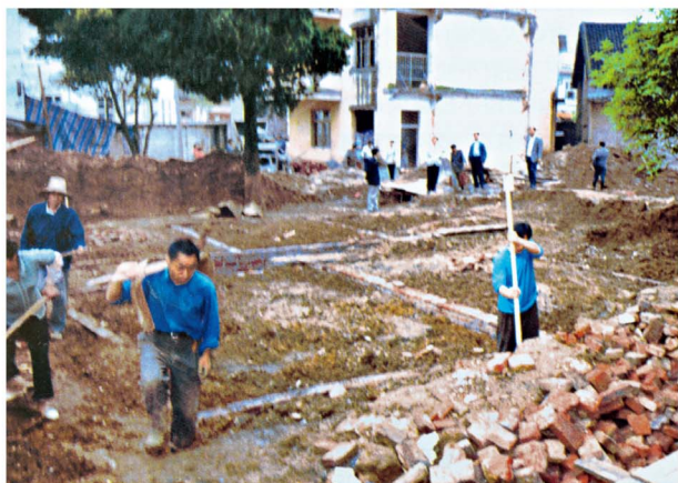
粵北「新亞醫院」動工。
