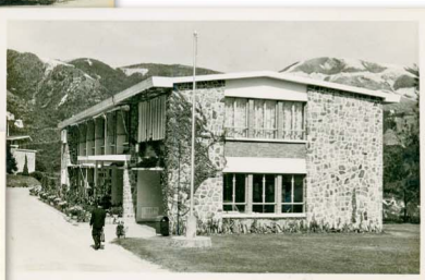
▼ 崇基學院行政辦公樓在1956年落成，並於1996年拆卸，現址為利黃瑤壁樓。
