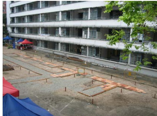
照片八：昔日中央書院的地基
